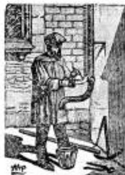
Plomero soldando una tubería
