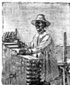
Albañil construyendo una pared de ladrillos
